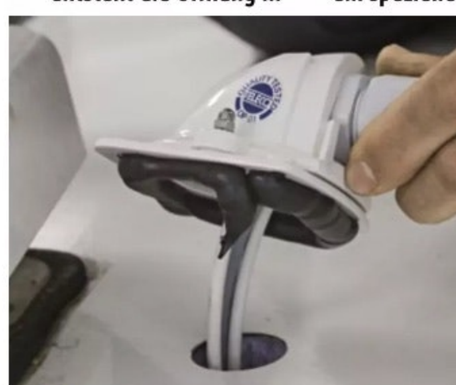
8 Das Gehäuse wird per Spezialkleber gleichzeitig fixiert und abgedichtet.
