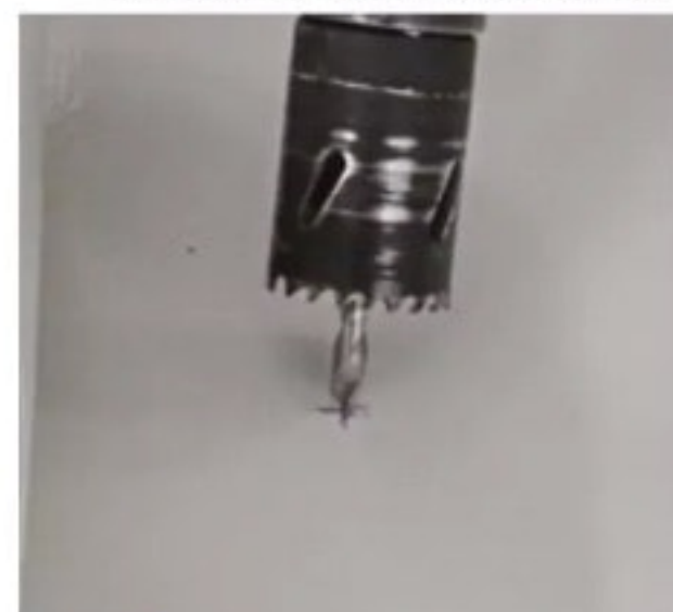
6 Mittels Lochsäge entsteht die Öffnung ...
