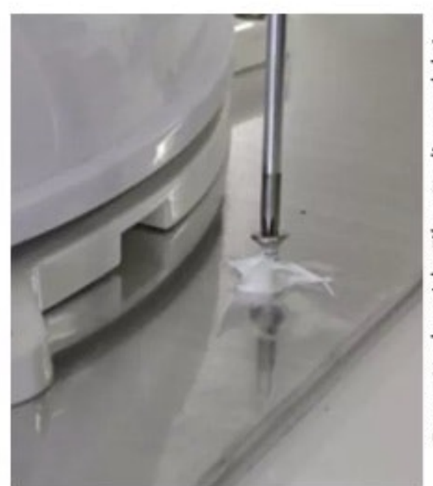
5 Schrauben fixieren den Sitz der Basisplatte zusätzlich.
